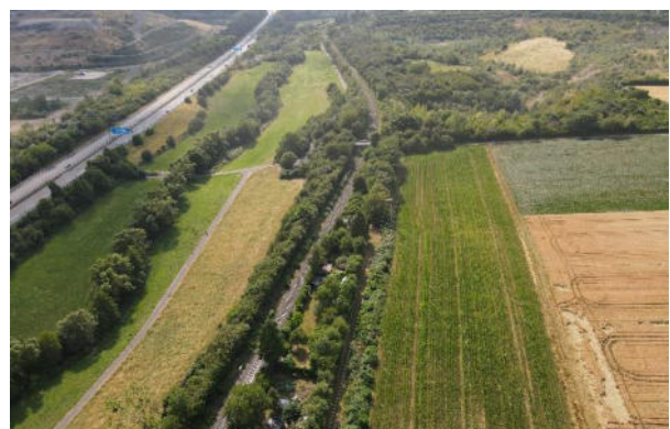
8: Blick auf die Trasse der Ländchesbahn, rechts Biotop Kalkofen, links A66
