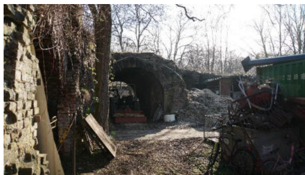
13: Blick auf Kasematten des Forts und jetziger Zustand
