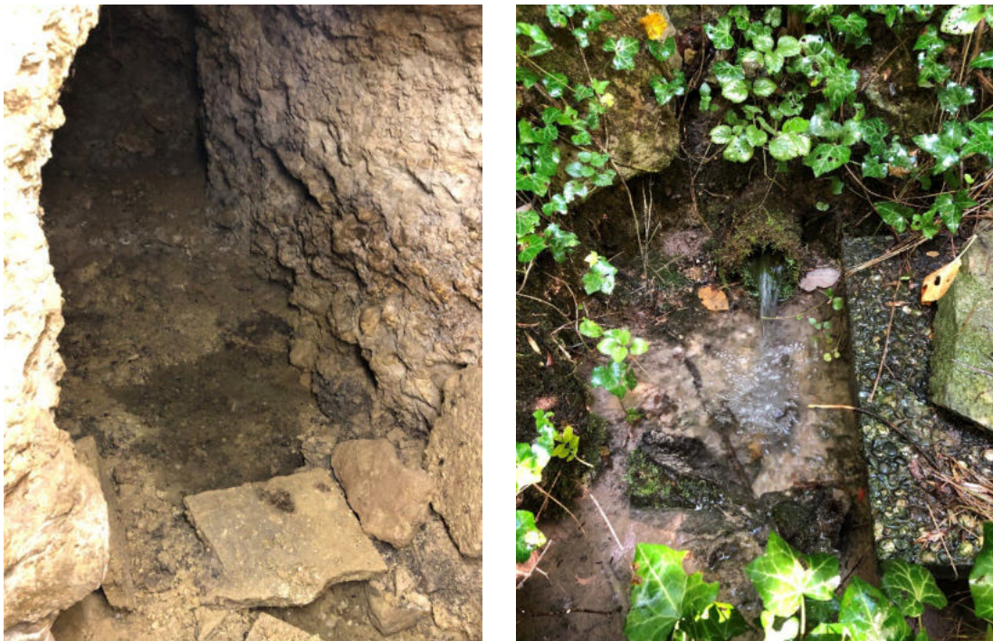
Abbildung 4: Austritt Quelle 2 im Stollen (links) bzw. nachgeschalteter Fassungsbereich (rechts)
